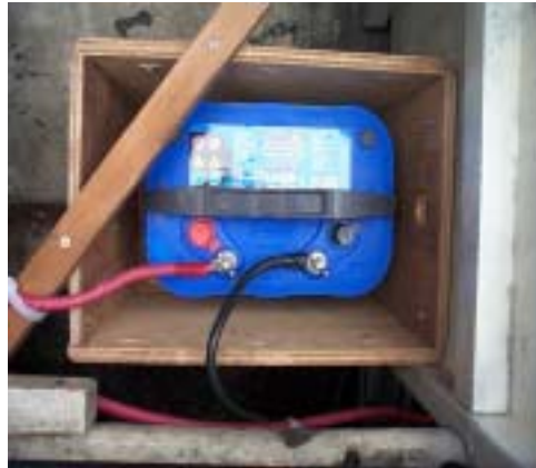
コックピットロッカーの下に箱を作りオプティマ・バッテリーを入れました
