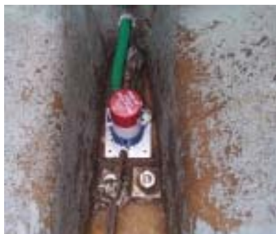
手動とは別に電動ビルジポンプを増設
