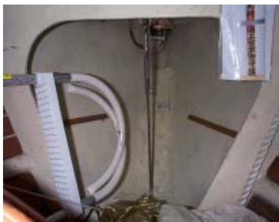
アイを下に引っ張りデッキが捲り上がる事の無いようにしました
